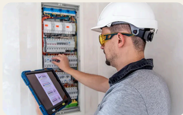
Analisi del rischio elettrico
